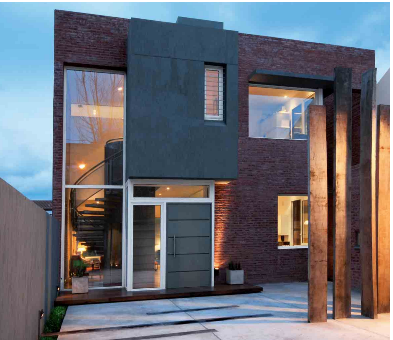
Ramen zijn overheersende vormgevingselementen.
